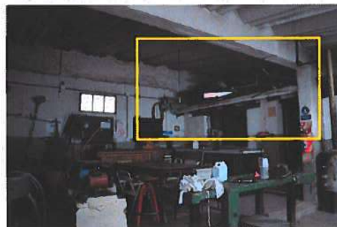
Demolición de bajo techo y completamiento con muro hasta la nueva cubierta
